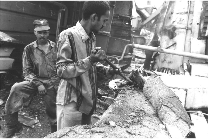
Foto 17: Asbest ausbrechen im Freizeithemd
