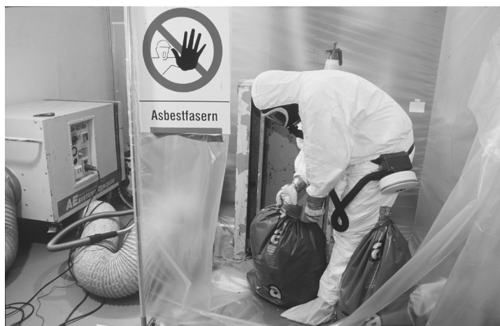
Foto 19: Asbestsanierung in Deutschland
